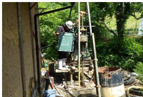
令和3年度実施箇所（広瀬町西谷）施工中
