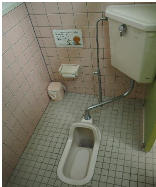
和式トイレ改修
