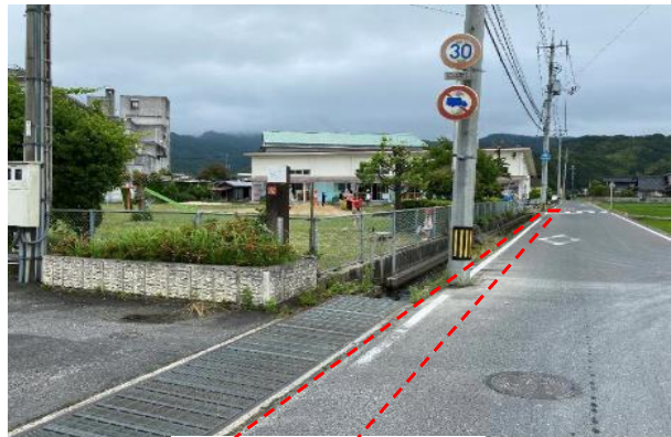
通学路安全対策 (飯梨工区)
