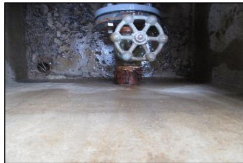
腐食した水道管の改修を行い、安全を確保する。
