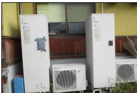
老朽化により故障した給湯器の更新を行う。
