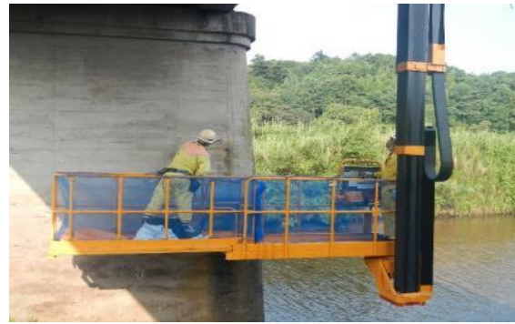
橋梁点検車による点検状況(下部)
