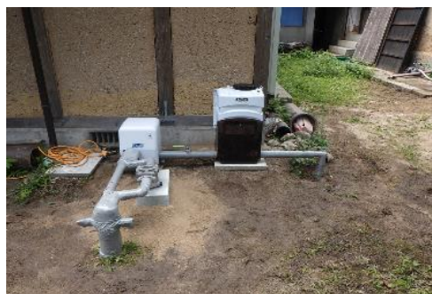
令和3年度実施箇所（広瀬町西谷）施工後
