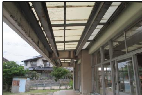
老朽化したテラスの改修を行い、安全を確保する。
