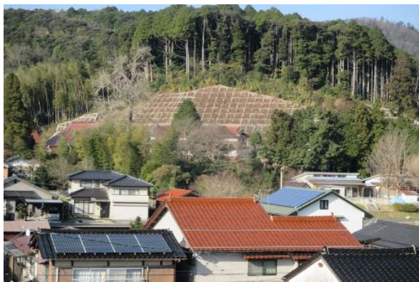
急傾斜地崩壊対策事業 目谷地区
