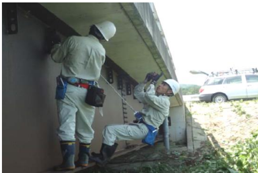
ロープアクセスによる点検状況
