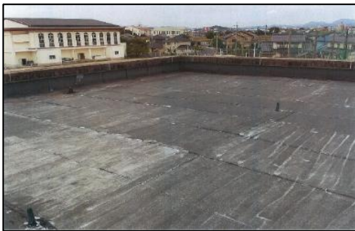
老朽化した屋上の改修を行い、雨水の侵入を防ぐ。
