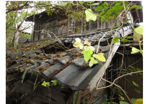
令和7年度に補助事業を活用して 除却した空き家
