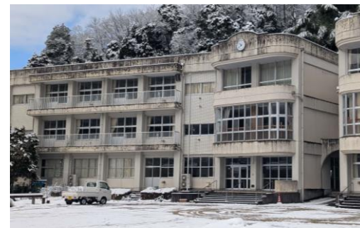
山佐交流センター機能の 移転先である旧山佐小学校舎
