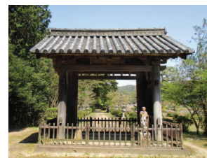
修理を行う雲樹寺四脚門
