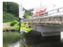
橋梁点検車による点検状況
