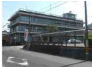
築後50年を経過する広瀬庁舎
