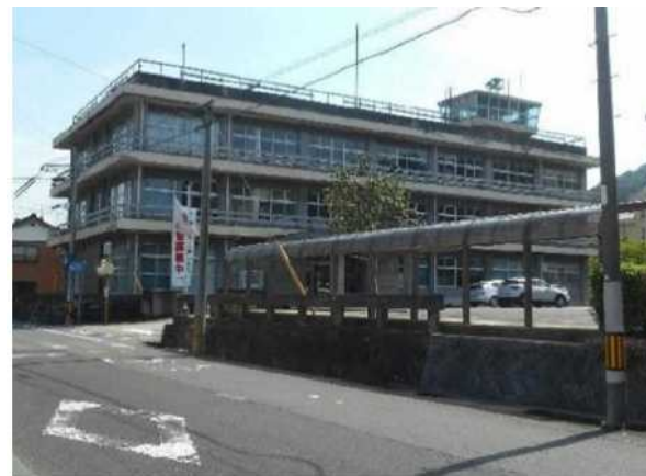
築後50年を経過する広瀬庁舎
