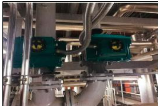
②修繕料 冷却塔（ボイラ）のモーター部交換
