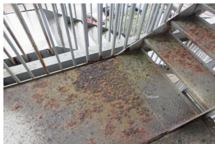
避難施設等改修工事
