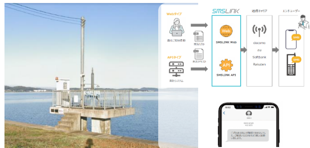
樋門写真と高潮連絡(SMS)
