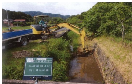
浚渫工事 状況写真(新川)
