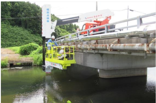
橋梁点検車による点検状況(上部)
