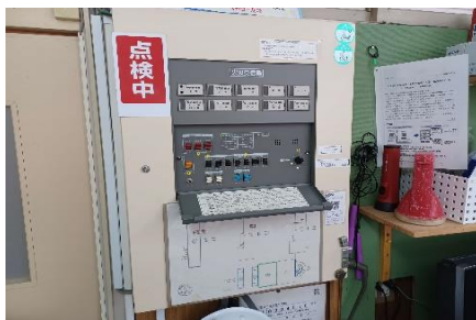
消防・防火設備改修工事
