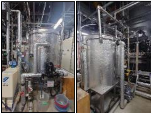
②修繕料 バイオマスボイラの補給水・冷却水配管修繕
