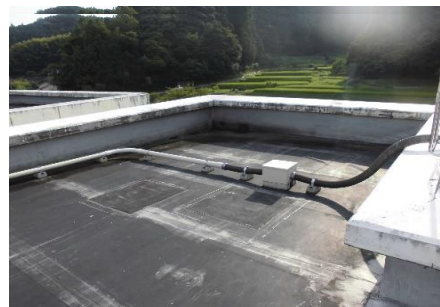
校舎等防水対策工事
