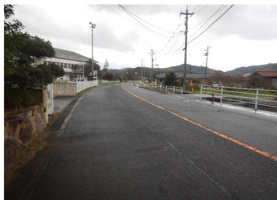
通学路安全対策 (区画線修繕)
