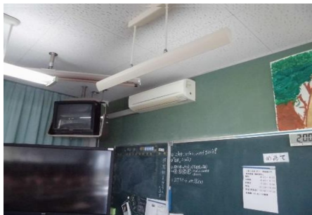
空調設備改修工事
