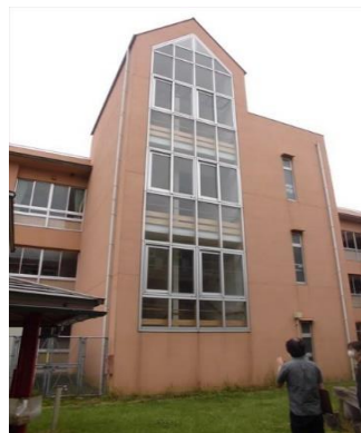
校舎等防水対策工事
