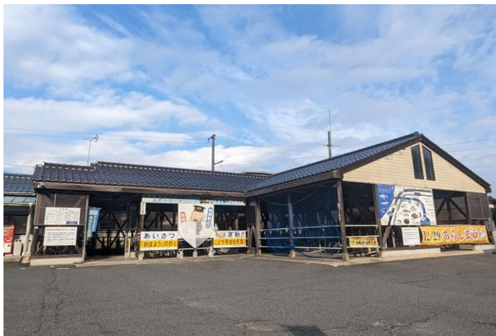
荒島駅前自転車駐車場
