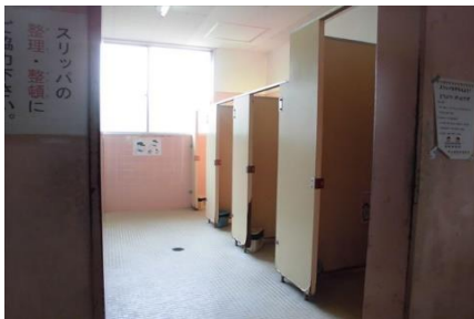
トイレ改修工事
