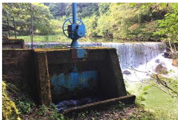
更新する導水路の取水口
