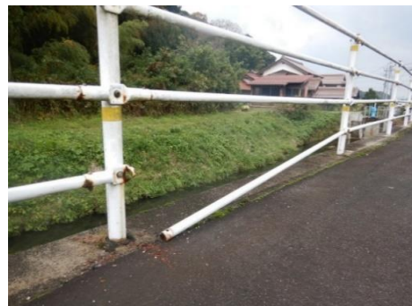
交通安全対策 (防護柵修繕)
