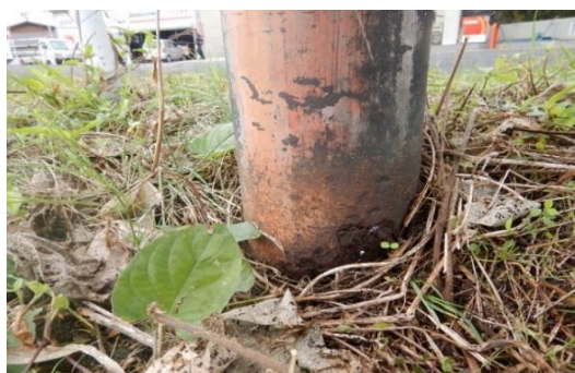
交通安全対策 (照明灯支柱取替)
