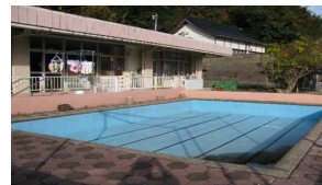
認定こども園荒島第一園舎プール修繕工事
