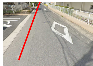
通学路安全対策 (区画線修繕)
