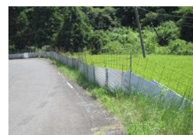
鳥獣被害防止対策補助金による柵設置状況
