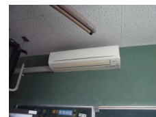
空調設備改修工事
