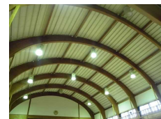
屋内運動場照明設備等改修
