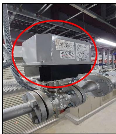
バイオマスボイラーの吸収式冷凍機の安全遮断弁のバッテリー交換
