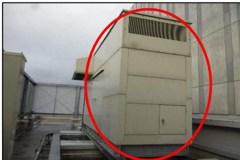
2階屋外キュービクル置場の非常用発電機の潤滑油・フィルター等の交換
