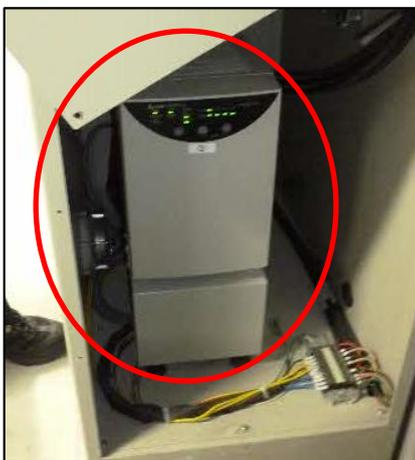
バイオマスボイラー制御関係の精密機器のバッテリー交換
