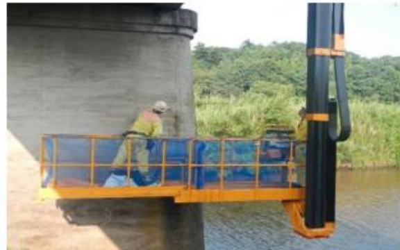
橋梁点検車による点検状況(下部)
