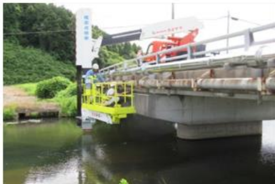
橋梁点検車による点検状況(上部)
