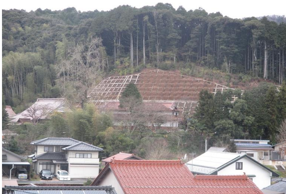
目谷地区急傾斜地崩壊対策事業
