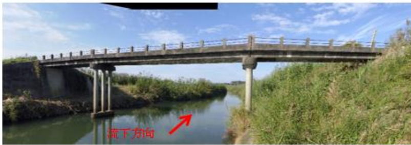
全景（清井2号橋）
