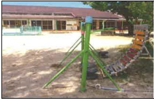
認定こども園広瀬 鉄棒 支柱が腐食し、傾いているため、 改修し、安全を確保する。
