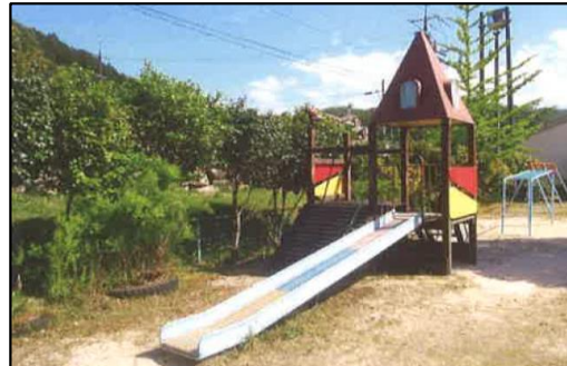
認定こども園布部 コンビネーション遊具 全体的に老朽化し、危険なため撤去。滑り台のみ使用可能な状態に改修する。
