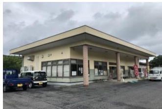
多機能拠点施設整備 (比田いきいき交流館)
