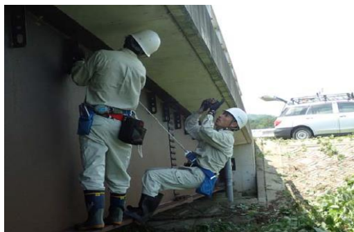
ロープアクセスによる点検状況
