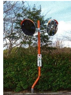
交通安全対策 (カーブミラー設置)
