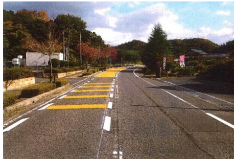
交通安全対策 (区画線補修、カラー舗装設置)
