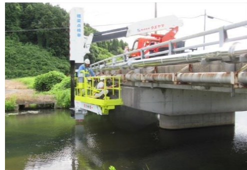
橋りょう点検車による点検状況
