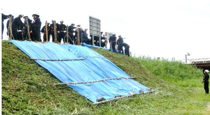
水防訓練（シート張り工法）
