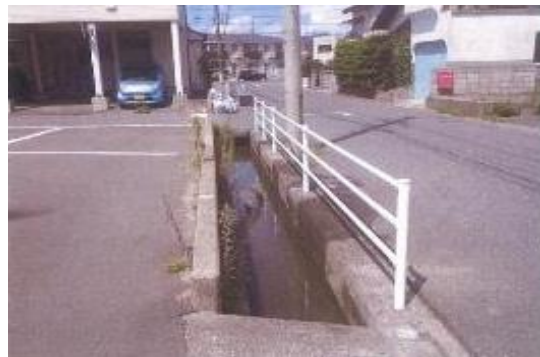
転落防止柵設置
