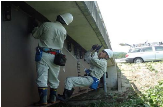
ロープアクセスによる点検状況
