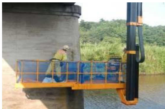
橋りょう点検車による点検状況
