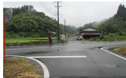
交通安全施設現場検証
