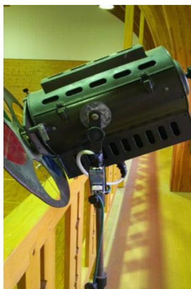
老朽化し漏電の可能性があるスポットライト（第二中学校）
