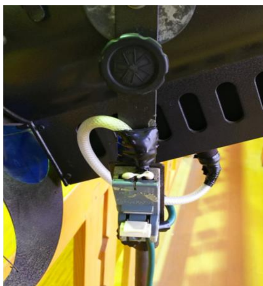
老朽化し漏電の可能性があるスポットライト（第二中学校）
