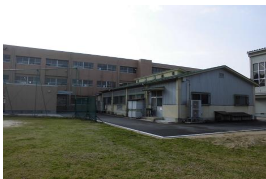
社日小給食室現況（解体）
