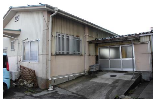
赤江小給食室現況（給食配膳室へ改修）
