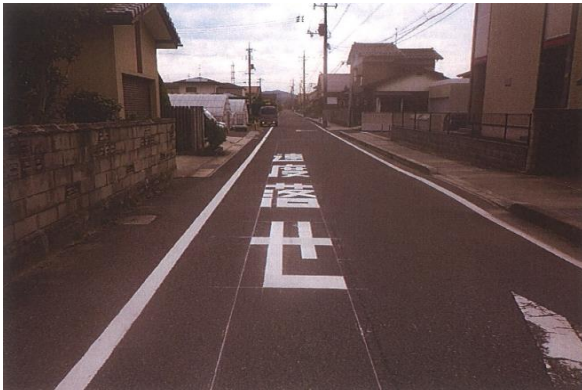
通学路安全対策 (区画線設置)
