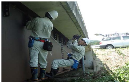
ロープアクセスによる点検状況
