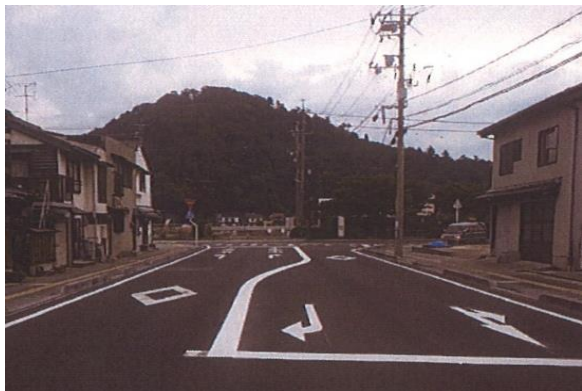
交通安全対策 (区画線修繕)
