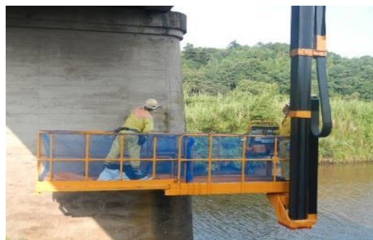
橋梁点検車による点検状況
