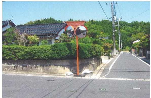
交通安全対策 (カーブミラー設置)
