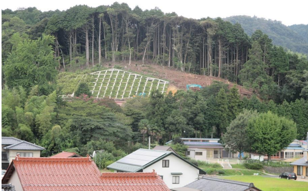
目谷地区急傾斜地崩壊対策事業
