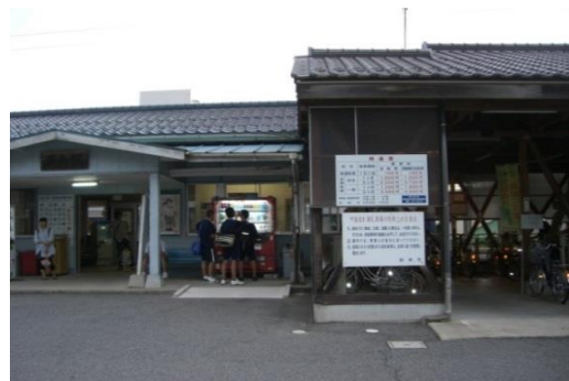
(荒島駅前自転車駐車場)
