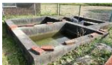
防火水槽改修工事（久根地区浄水場）
