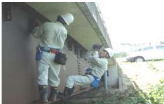
ロープアクセスによる点検状況
