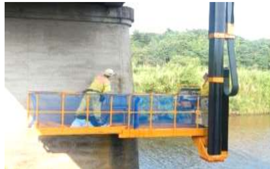
橋梁点検車による点検状況
