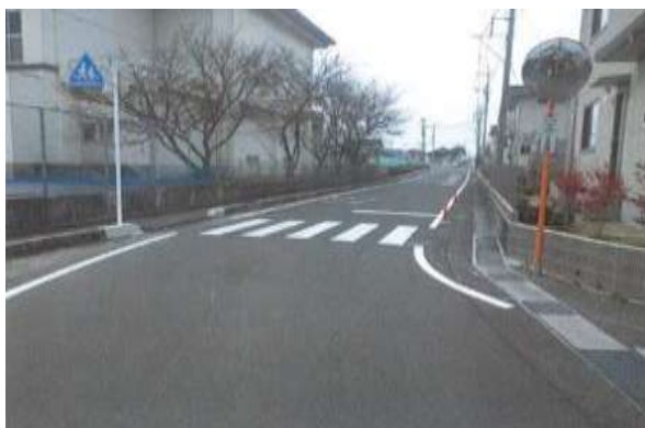
通学路の安全対策 (区画線・ポストコーン設置)
