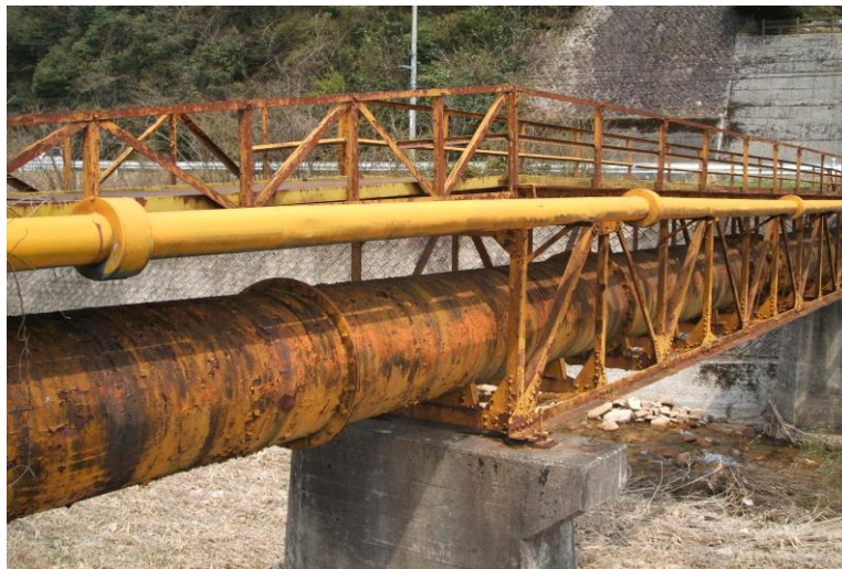
布部発電所 水路橋（昭和29年建設）
