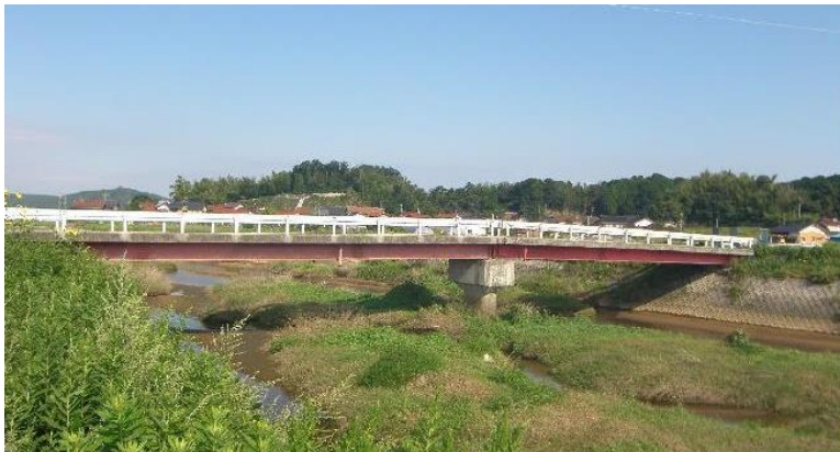
焼野橋の全景写真(L=42.8m)
