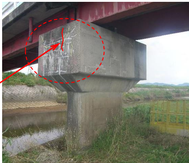
焼野橋の橋脚部分の写真
