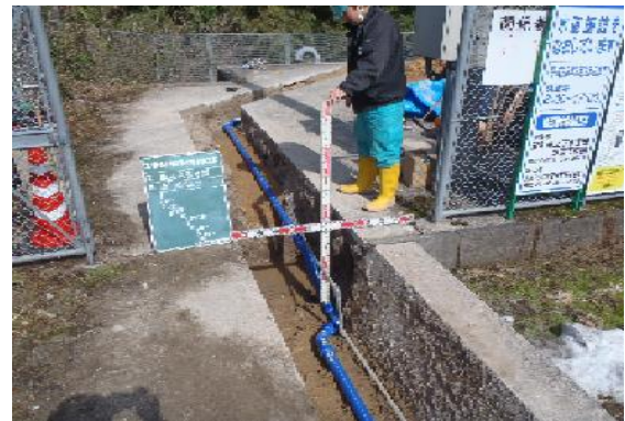
西谷浄水場改良工事
