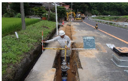
上山佐中口地内配水管改良工事
