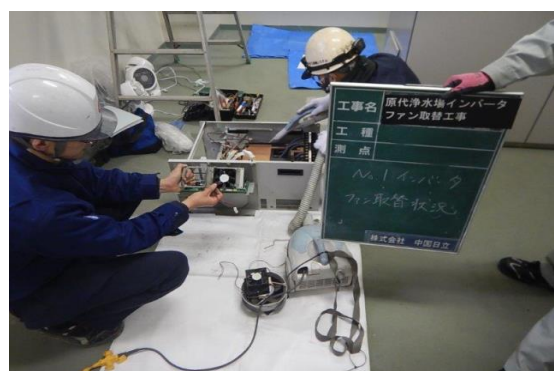
原代浄水場インバータファン取替工事
