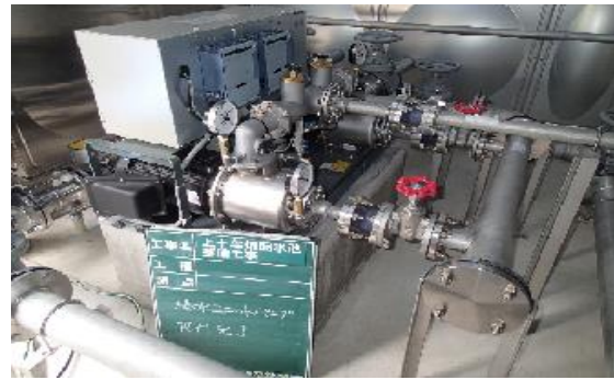
上十年畑配水池整備工事
