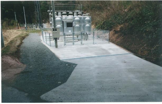
上十年畑配水池築造工事
