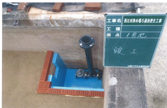
西比田浄水場ろ過池更生工事
