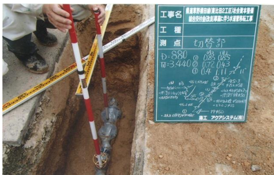
一般県道草野横田線（東比田2工区）社会資本総合整備交付金（改良）事業に伴う水道管移転工事
