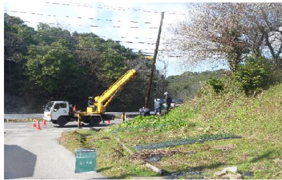
伯太地区電柱撤去工事
