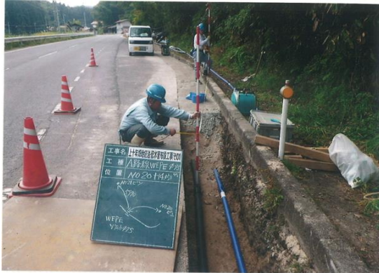
上十年畑地区送・配水管布設工事（その1）
