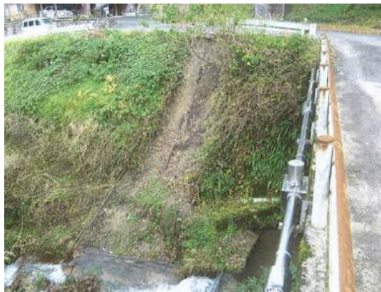
単独災害 布部西谷線道路災害復旧工事 着手前
