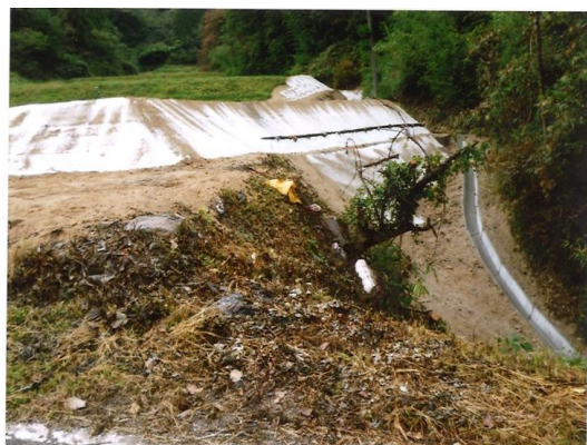
後ヶ市水路災害応急工事
