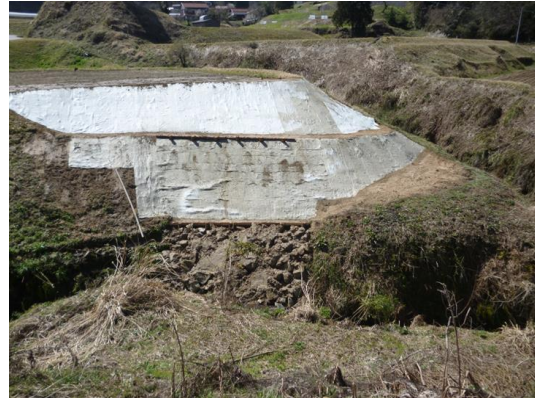
田中水路災害応急工事
