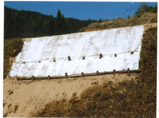
仲村農道災害応急工事
