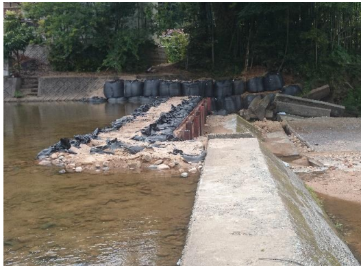
城山頭首工災害応急工事
