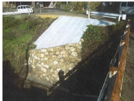
単独災害 布部西谷線道路災害復旧工事 竣工
