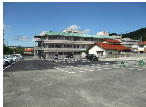
健康福祉センター駐車場整備後
