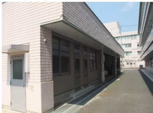
健康福祉センター車庫改修後
