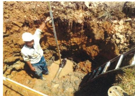
用水管漏水修理（施工）
