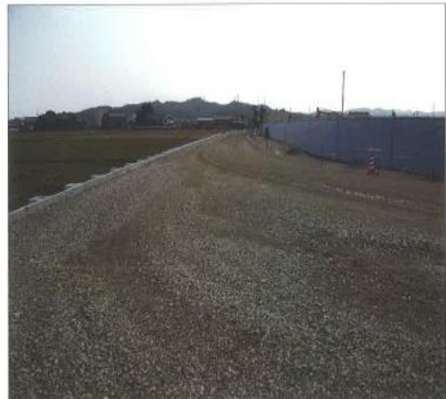
竣工 西側⇒東側
