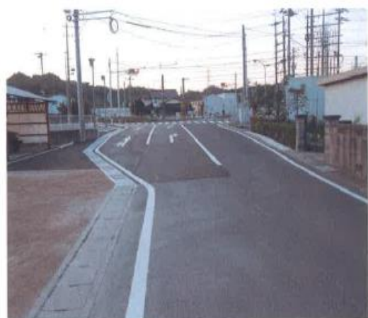
竣工(防災・安全交付金事業和田1号線道路改良工事)
