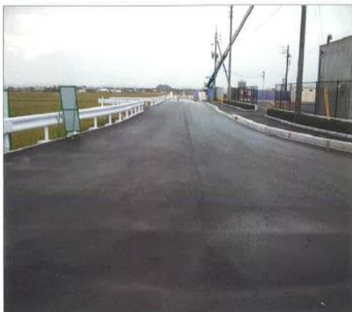
竣工 北側⇒南側
