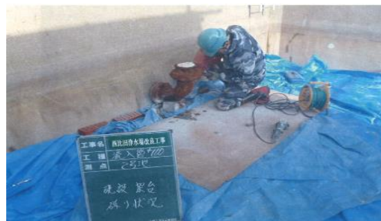
西比田浄水場改良工事
