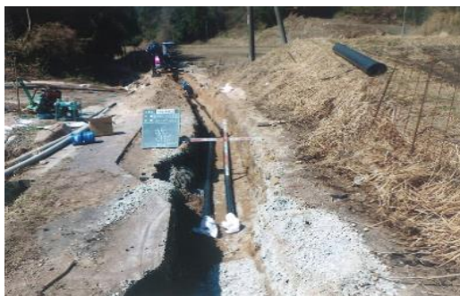
小竹浄水場付近送水管改良工事
