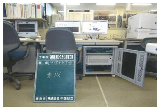
遠隔監視システム整備工事
