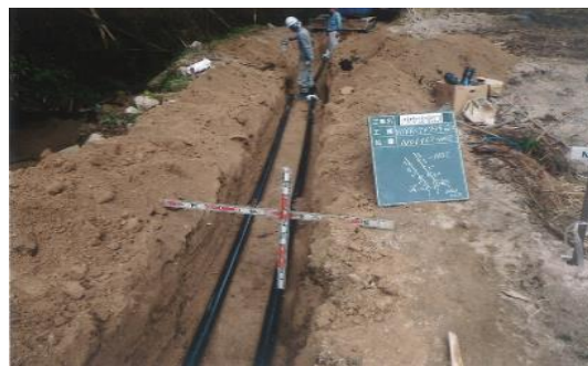
小竹浄水場付近送水管改良工事
