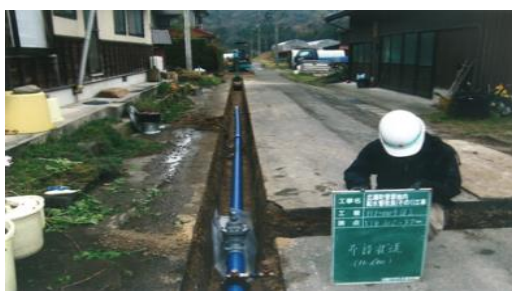
菅原市原地内配水管改良工事
