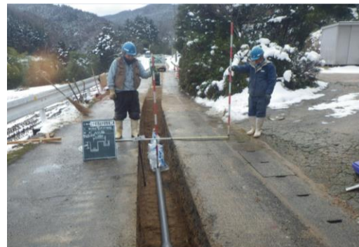
上十年畑送水管整備工事
