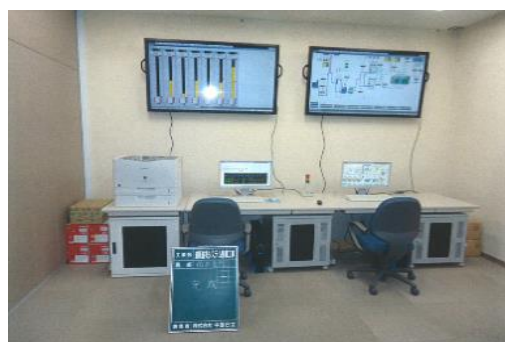
遠隔監視システム整備工事
