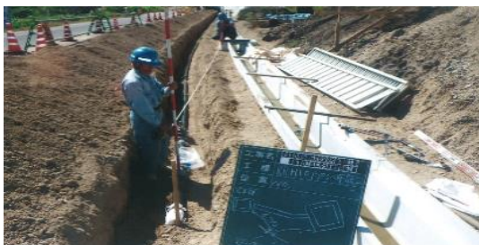
県道草野横田線防災安全交付金(建設公共)事業(草野工区)に伴う水道管移転工事
