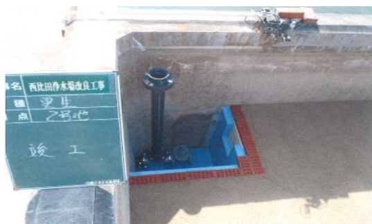
西比田浄水場改良工事
