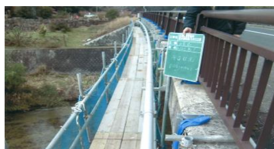
菅原市原地内配水管改良工事
