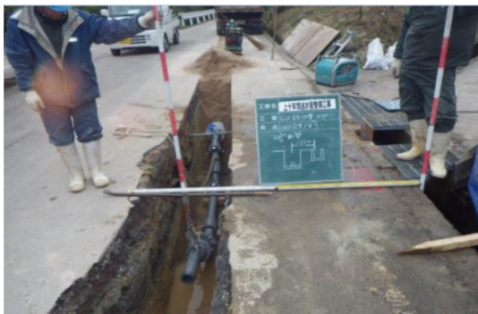
上十年畑送水管整備工事
