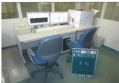
遠隔監視システム整備工事
