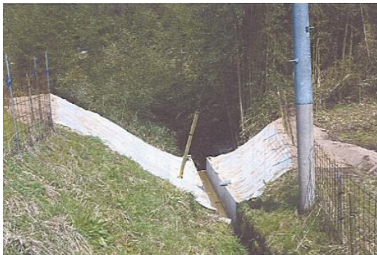
横屋水路災害応急工事
