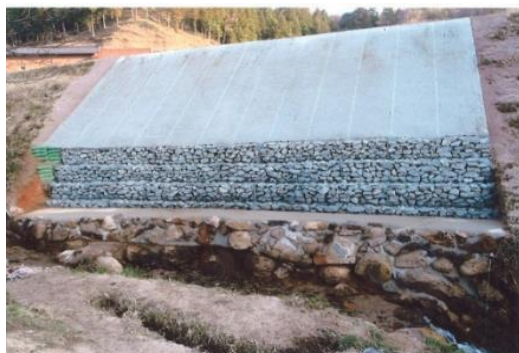
19/72新田谷農地災害復旧工事
