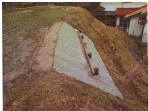
久根農地災害応急工事
