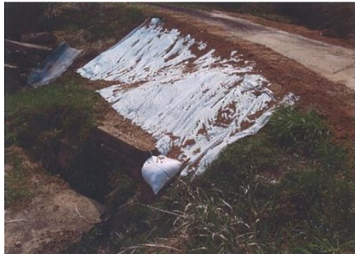
上ヶ保水路災害応急工事
