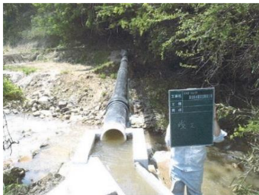
103/72落合原水路災害復旧工事
