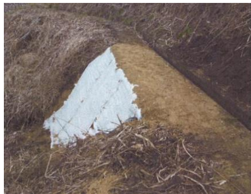
道城水路災害応急工事
