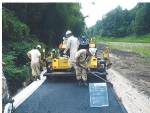
111/72永江道路災害復旧工事
