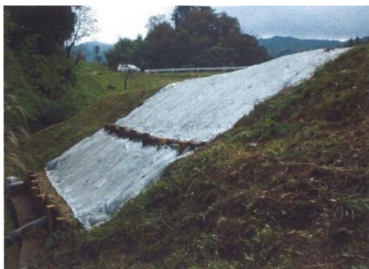
滝谷農地災害応急工事
