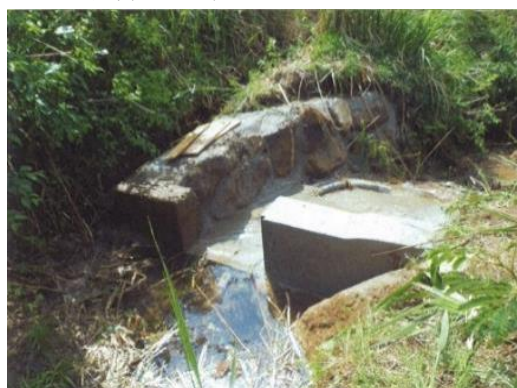
久の谷頭首工災害応急工事
