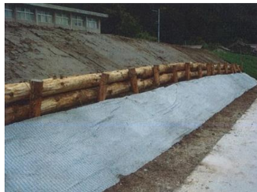
西母里農地災害応急工事
