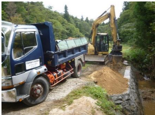
福留農道災害応急工事
