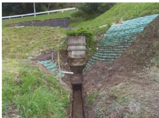
赤屋水路災害応急工事
