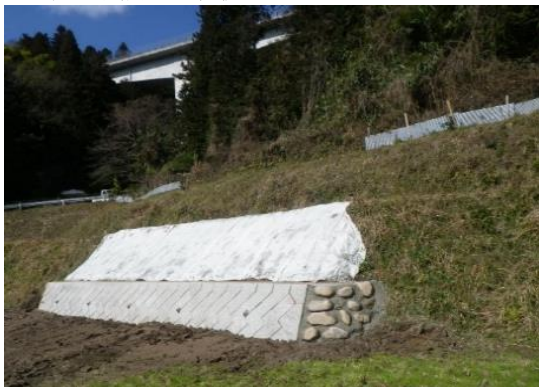
祖父谷農地災害復旧工事
