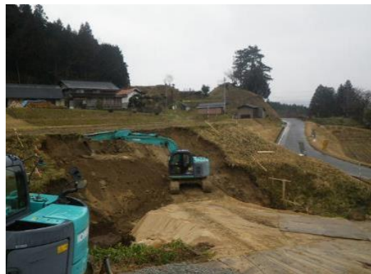
虫木農地災害復旧工事
