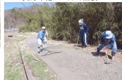
長寿命化 コンクリート舗装
