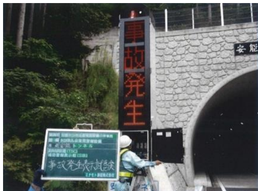
安能トンネル安全施設点検業務
