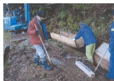
共同活動 水路の敷設
