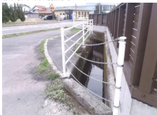
城谷排水路防護柵設置工事
