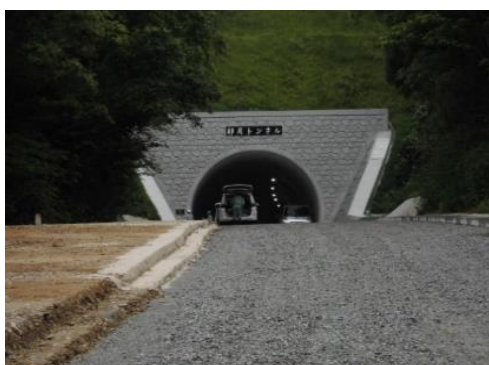
安能2期 卯月トンネル
