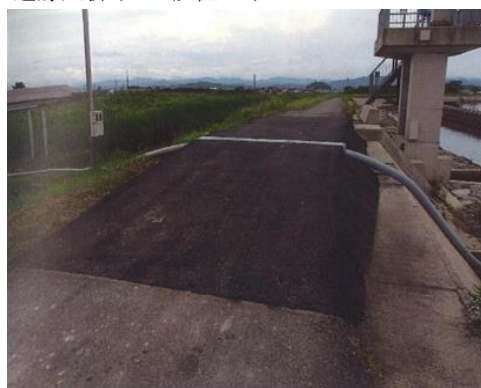
遠藤川排水ホース設置工事
