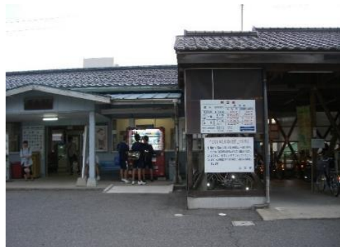
荒島駅前自転車駐車場
