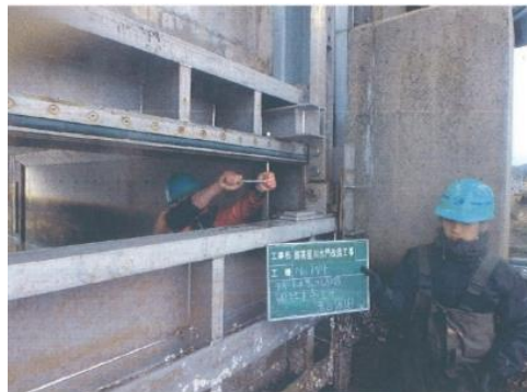
御茶屋川水門改良工事 親子ゲート水密ゴム取替
