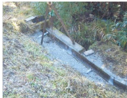
西谷水路修繕
