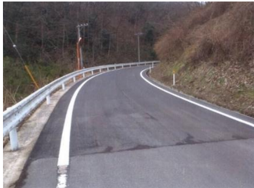
笹刈農道舗装修繕工事 竣工
