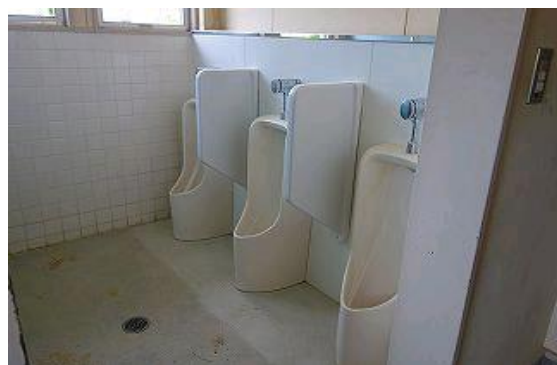
■安来球場管理棟トイレ水洗化（下水道接続）
