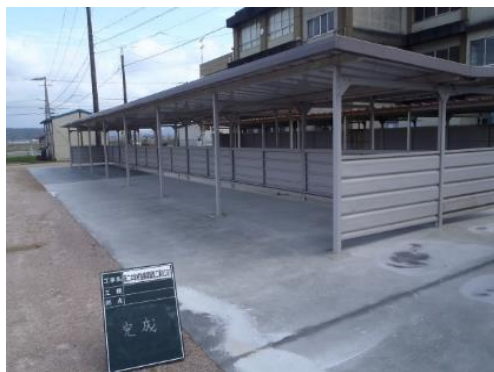
第二中学校駐輪場舗装工事
