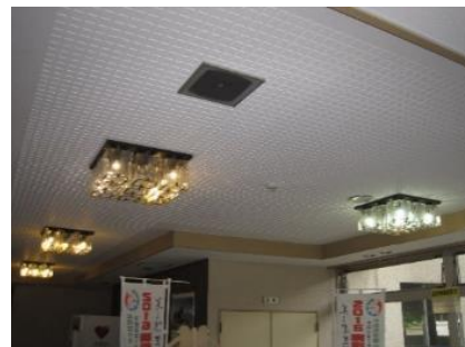
安来中央交流センター改修工事 (1階天井改修工事)
