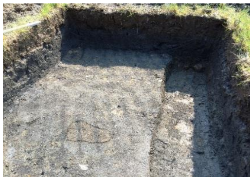
▲通信設備建設工事に伴う試掘調査
