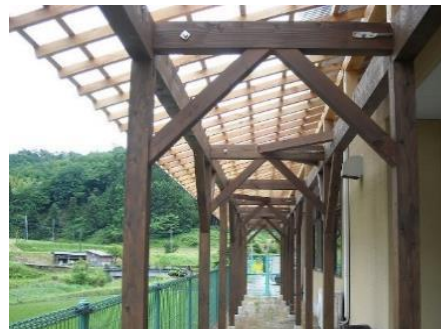
奥田原交流センター庇増築工事
