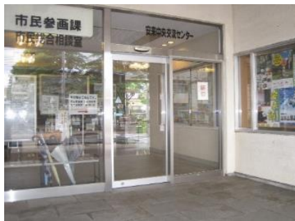
安来中央交流センター改修工事 (入口自動ドア工事)
