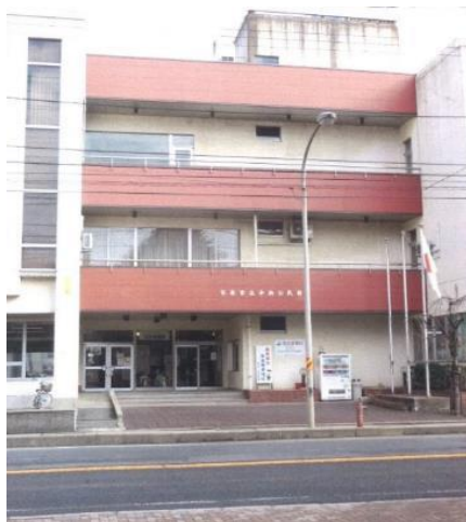
安来中央交流センター外壁改修工事
