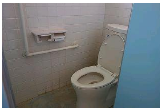
■安来球場管理棟トイレ水洗化（下水道接続）
