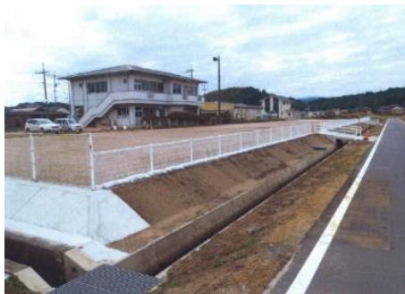
大塚交流センター駐車場及び多目的広場
