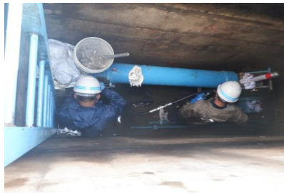
富田頭首工転倒ゲート緊急修繕工事
