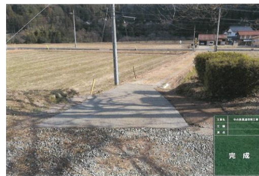
長寿命化活動（農道コンクリート舗装）
