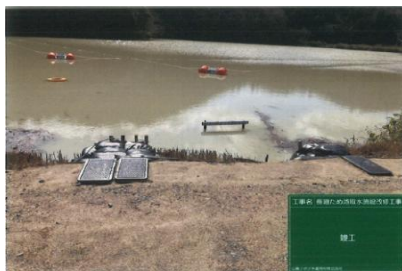
長廻ため池取水施設改修工事
