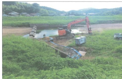
伯太川佐久保水路渇水対策工事
