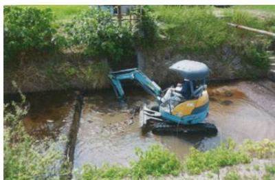
安田川未明堰取水工事
