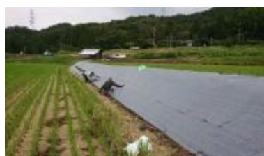
法面保護シート取り付け
