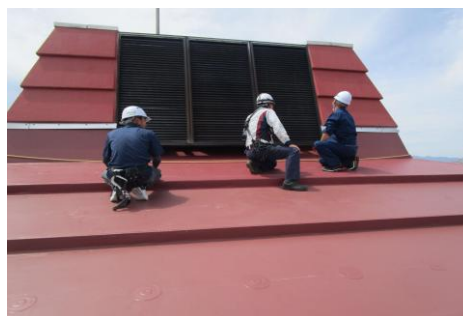
安来市民体育館屋根 現場確認
