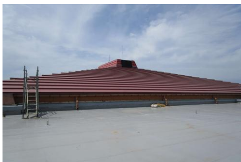
安来市民体育館屋根 現場確認
