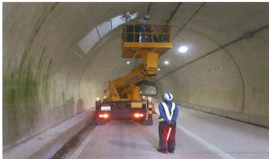
笹刈トンネル トンネル点検状況
