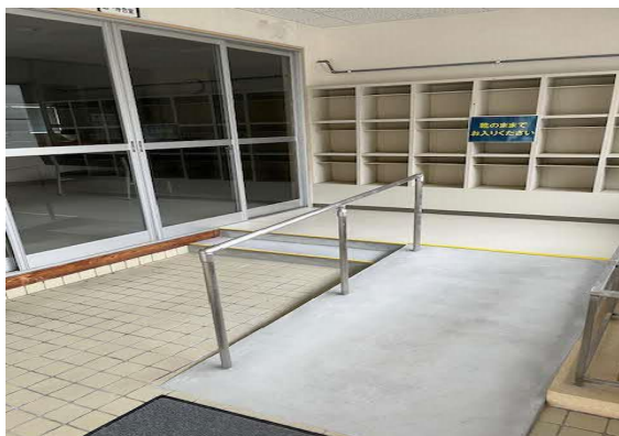
赤屋診療所・スロープ設置
