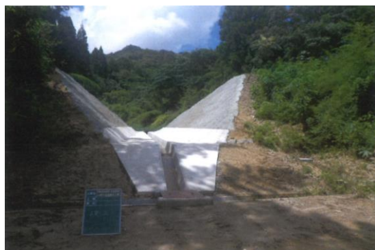
山根ため池廃止工事
