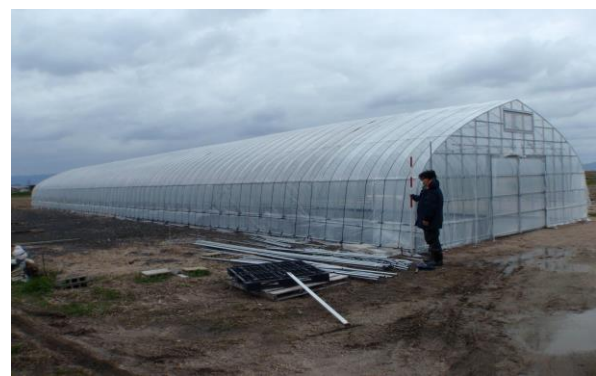
復旧状況（外観）
