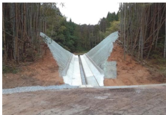
瀬谷ため池廃止工事
