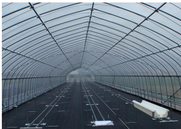
復旧状況（内観）
