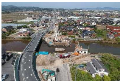
吉田橋橋梁下部工
