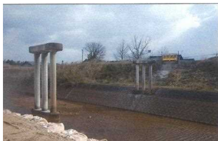
橋脚撤去 着工前
