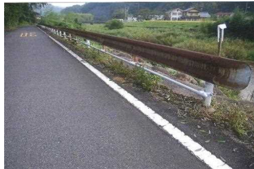
防護柵改修工事 完成写真
