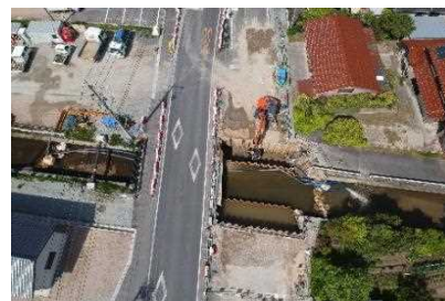
藤木橋（2期施工）
