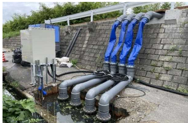
仮設ポンプ場整備状況
