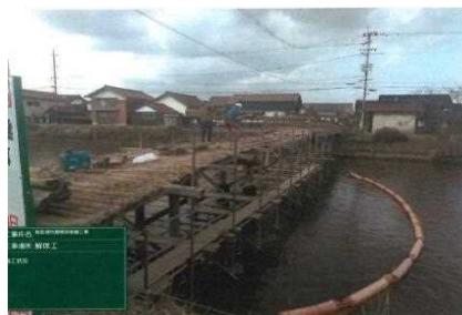
解体 作業写真
