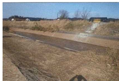
橋脚撤去 竣工
