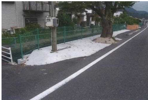
歩道拡幅・防護柵改修工事 完成写真
