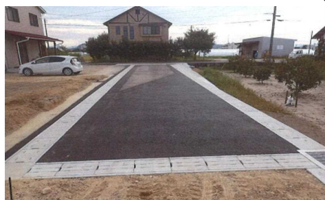
進入路道路工事
