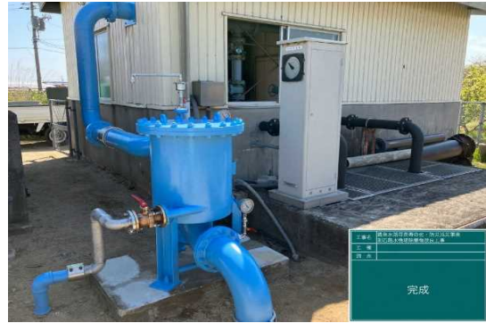
別石揚水機場 除塵機更新
