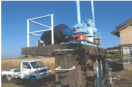
下坂田潮止水門修繕
