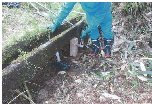
中ノ谷水路修繕
