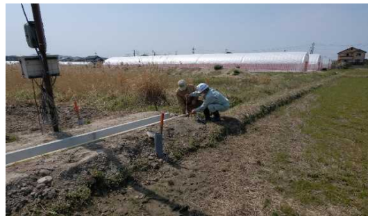
長寿命化活動（水路の再布設）
