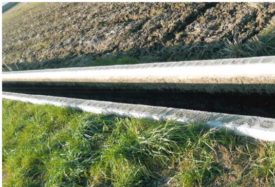
上荒島用水路修繕
