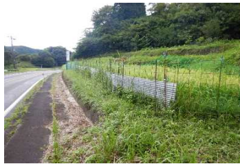
防護柵 設置状況
