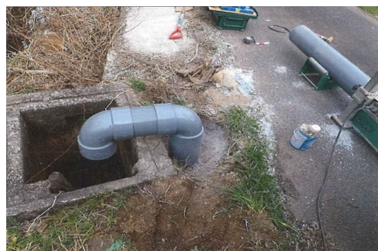
西荒島ポンプ場用水設備修繕
