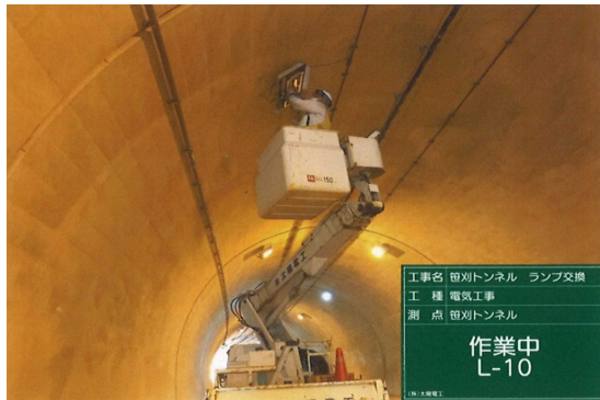
笹刈農道 トンネル照明修繕
