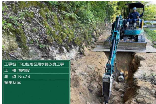
下山佐地区用水路改良工事
