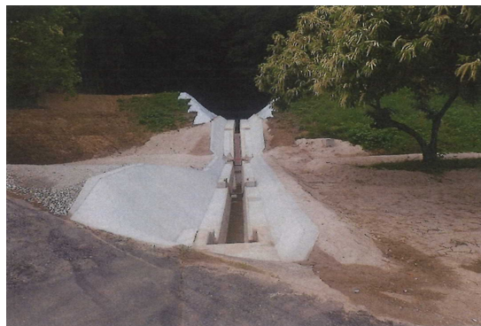
広ごん寺ため池廃止工事
