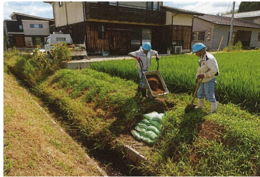
横山水路法面修繕
