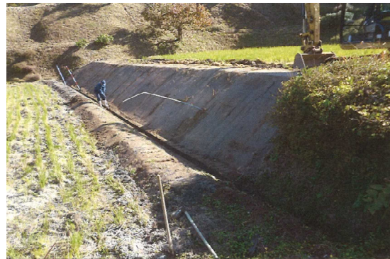
萱原水路修繕
