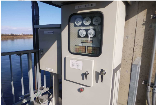
御茶屋川水門 自動開閉装置更新
