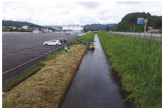
洞貫川古川地区除草業務
