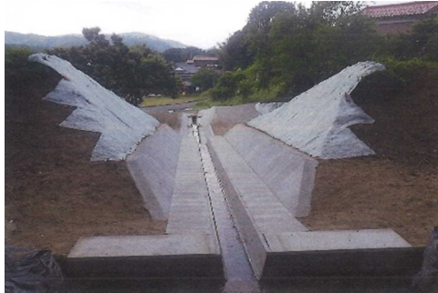
広ごん寺ため池 排水路整備
