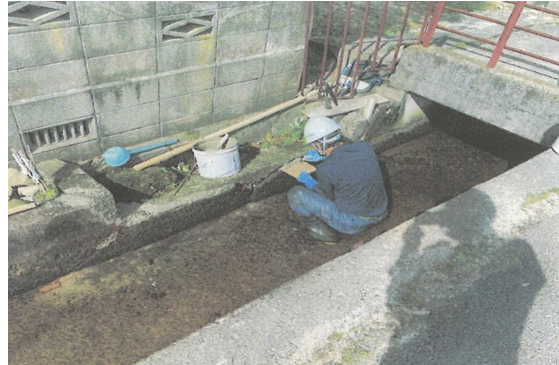
飯梨川左岸幹線用水路修繕
