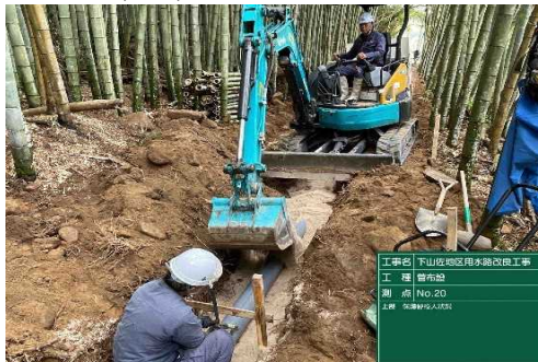
下山佐地区用水路改良工事
