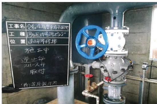
揚水ポンプ逆止弁更新
