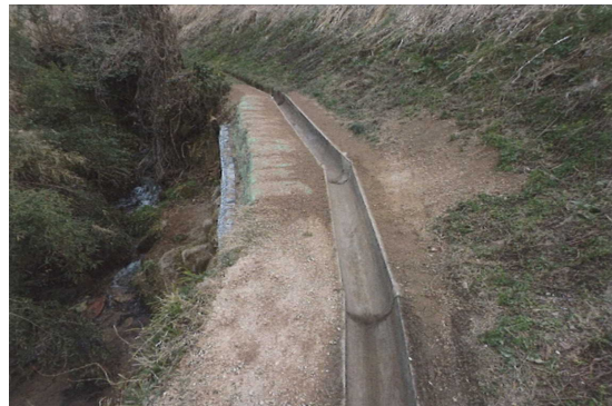
熊谷水路災害応急工事
