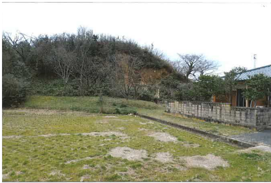
着手前（崩落状況）
