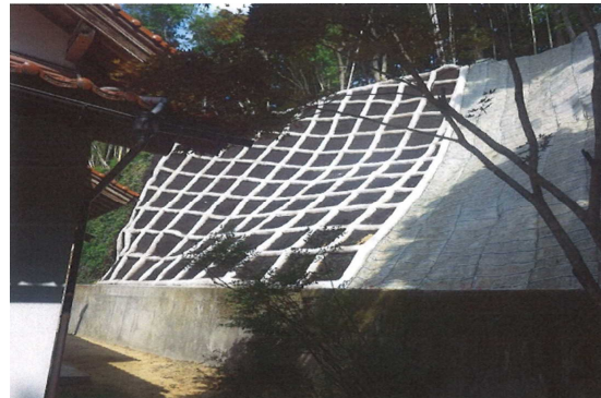
早田地区林地崩壊防止工事
