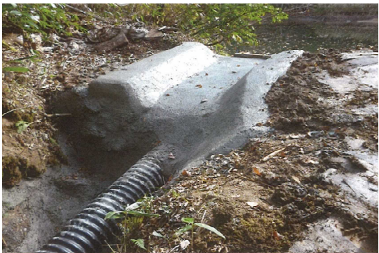
笹原ため池災害応急工事
