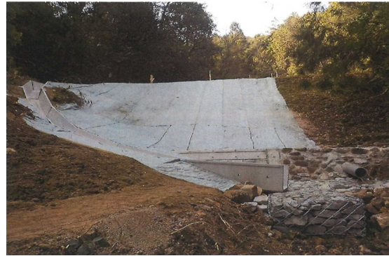
金山ため池(1)災害復旧工事
