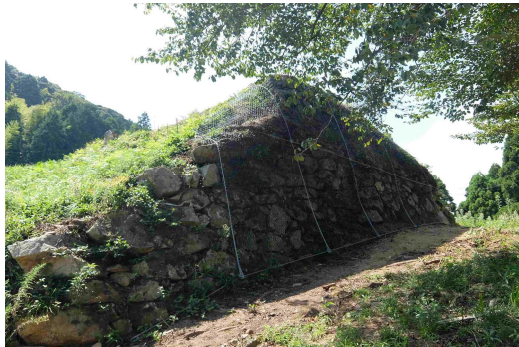
山中御殿大手門石垣復旧工事
