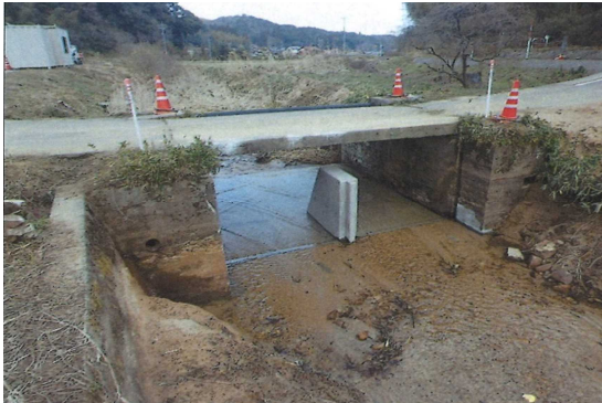
大光寺水路災害応急工事
