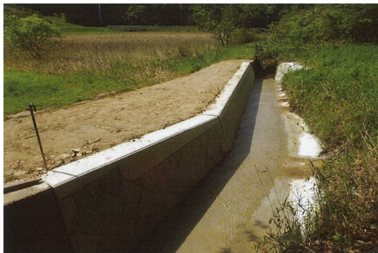
政下水路災害復旧工事
