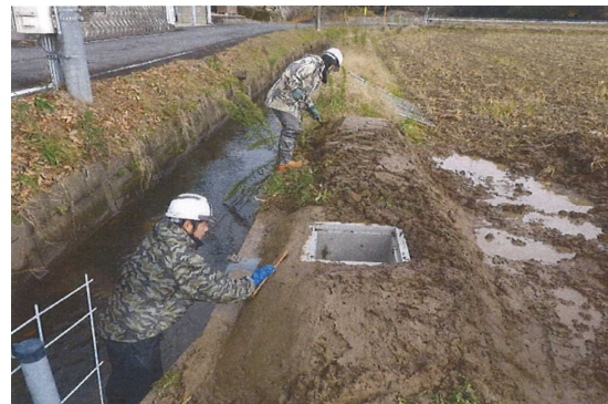
長田農地災害応急工事
