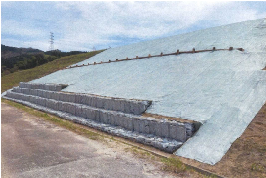
永江農地災害復旧工事
