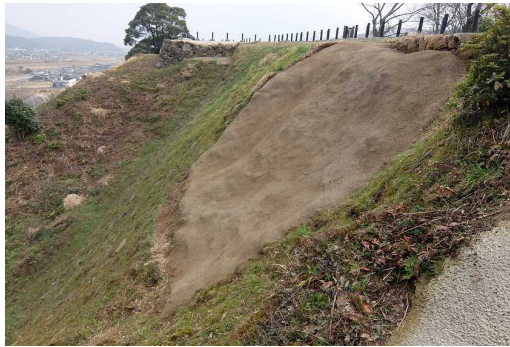
千畳平北石垣復旧工事
