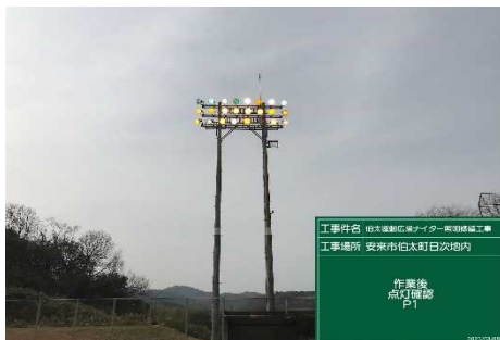
ナイター照明施工後
