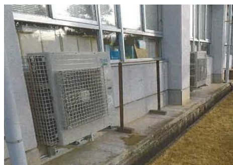
空調設備等改修工事（飯梨）
