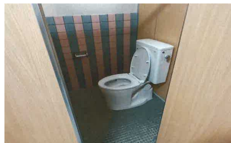
トイレ改修工事（三中）
