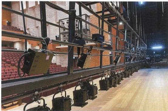
舞台照明設備修繕
