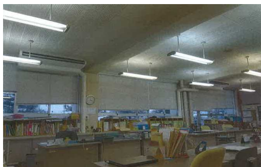
空調設備等改修工事（飯梨）
