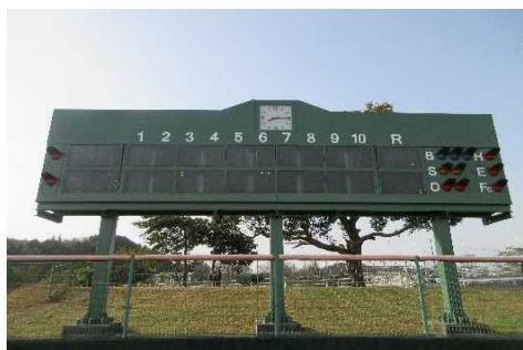
バックスクリーン施工後
