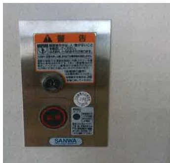
消防設備改修工事（一中）
