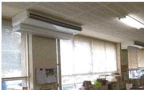
空調設備等改修工事（二中）
