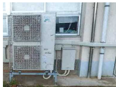
空調設備等改修工事（三中）
