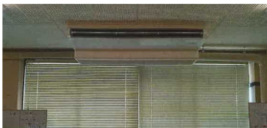
空調設備等改修工事（三中）
