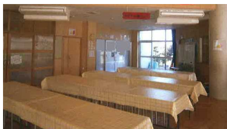
空調設備等改修工事（南）
