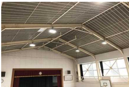
屋内運動場照明設備改修工事（井尻）
