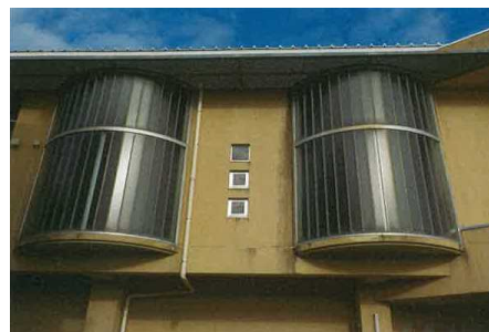
屋上等防水改修工事（三中）
