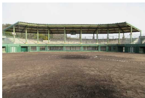
コンクリート壁面施工後
