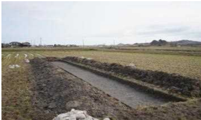
飯梨地区ほ場整備事業に伴う試掘調査調査状況
