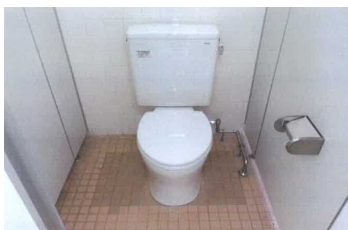
トイレ改修工事（十神）
