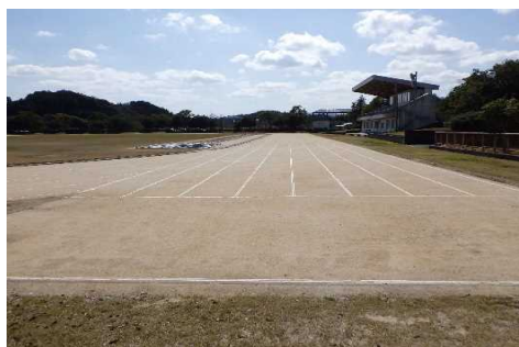
トラック施工後
