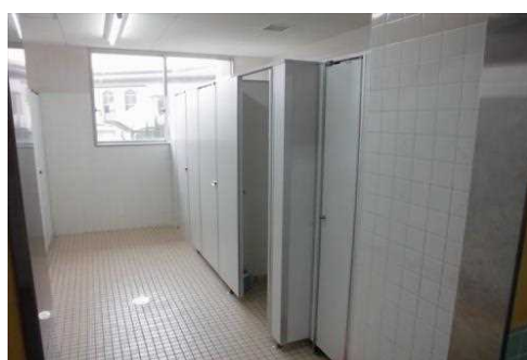
トイレ改修工事（十神）
