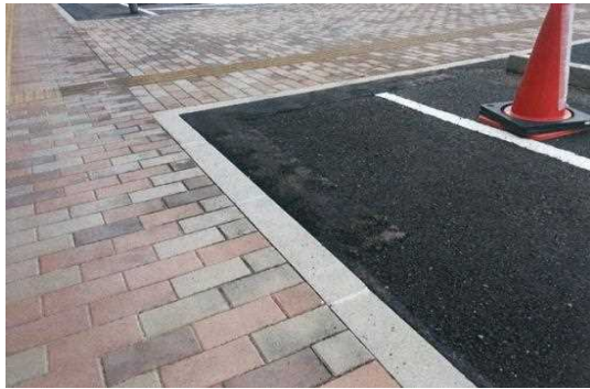
インターロッキング外修繕
