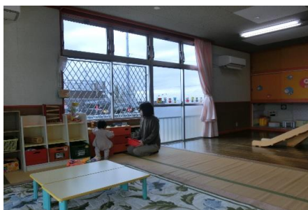
取替後の様子
