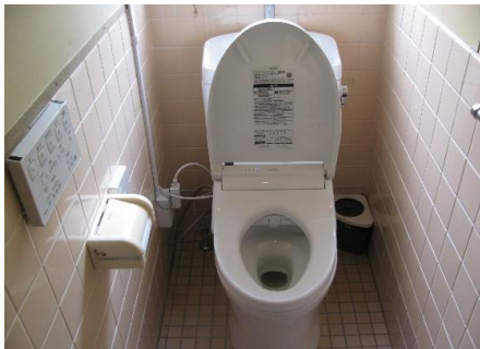
④認定こども園広瀬大人用トイレ改修工事
