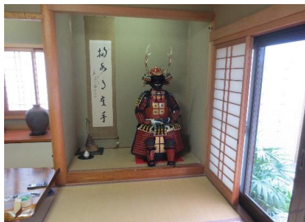
新六菩提寺鎧かぶと据付作業
