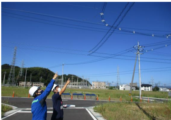
完了検査の様子
