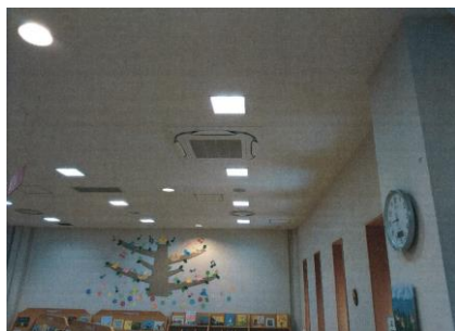
空調機器整備完了（北側）
