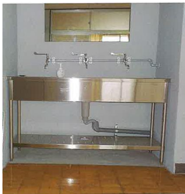
手洗い場改修工事（三中：教室棟）
