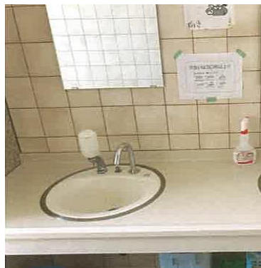
手洗い場改修工事（三中：体育館トイレ）
