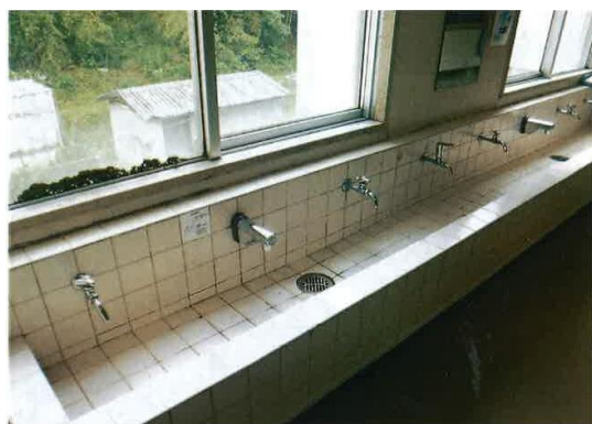
手洗い場改修工事（荒島：手洗い場）
