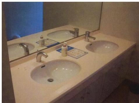
和鋼博物館 手洗い自動水栓化 整備状況
