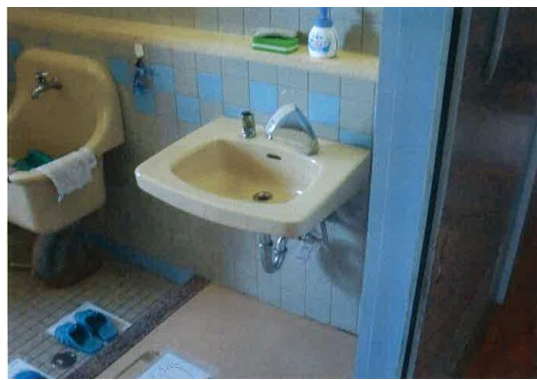
手洗い場改修工事（南：体育館トイレ手洗い場）
