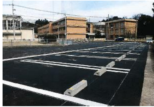
社日交流センター駐車場整備工事
