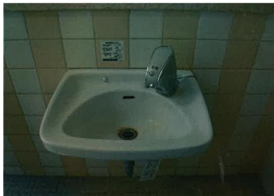
手洗い場改修工事（荒島：トイレ手洗い場）
