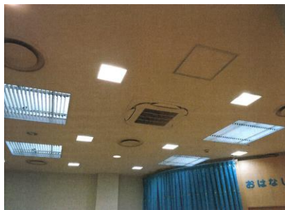
空調機器整備完了（西側）
