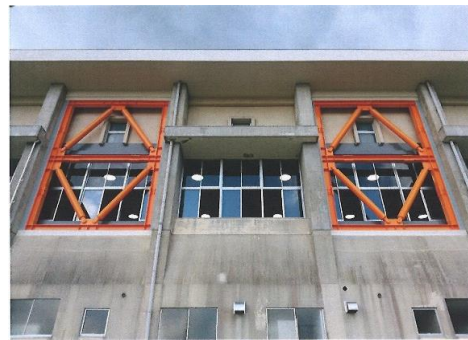
鉄骨壁ブレース取付による耐震補強
