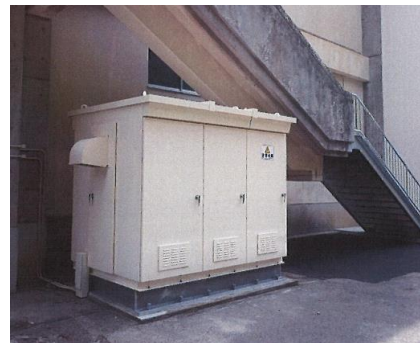
受変電設備（キュービクル）の更新
