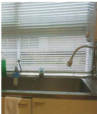
手洗い場改修工事（三中：保健室）
