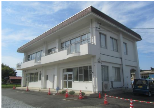
能義交流センター外壁塗装改修工事
