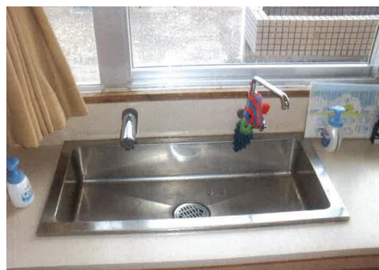
手洗い場改修工事（南：教室内手洗い場）
