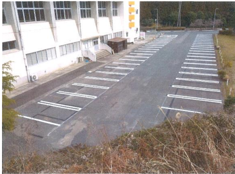
既存の体育館前駐車場に区画線を整備
