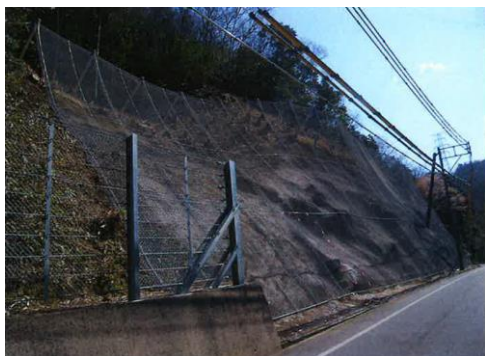
宇波尻線災害防除工事竣工写真①
