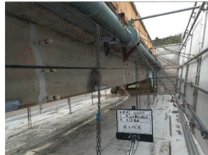
樹脂注入 作業写真
