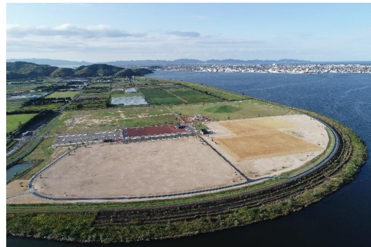
工事完了写真 (東エリア)
