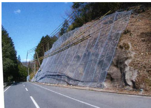
宇波尻線災害防除工事竣工写真②
