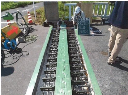
伸縮装置取替え 作業写真
