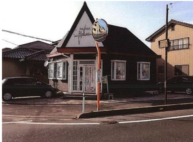
カーブミラー新設 (安来町地内)
