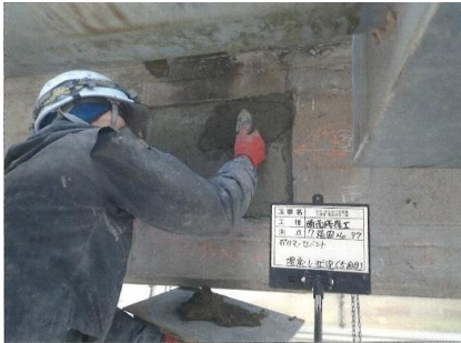
断面修復 作業写真
