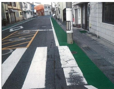
カラー舗装 新設 (安来町)
