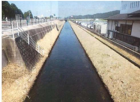
洞貫川古川地区除草業務
