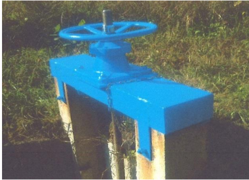
荒島樋水門修繕
