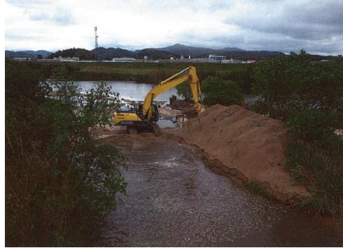
別石樋取水口土砂撤去
