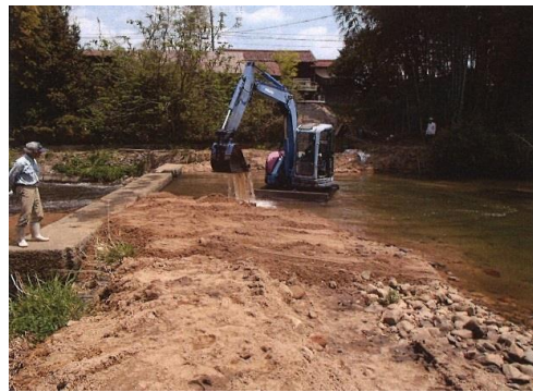
城山堰漏水修繕
