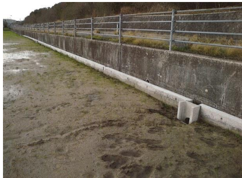
上坂田水路修繕
