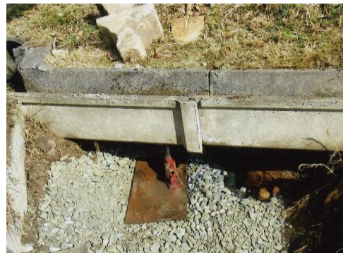
宇波滝下地内水路修繕
