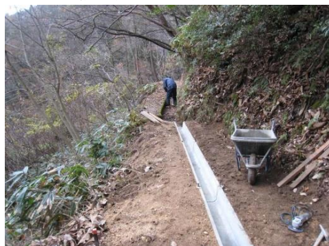
長寿命化活動（水路の更新）
