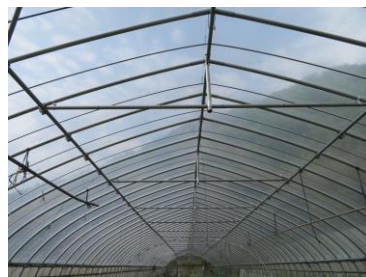
補強資材導入
