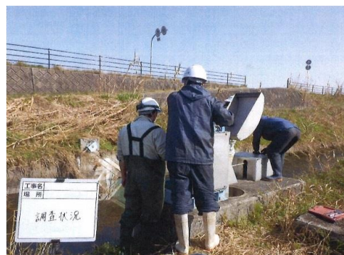
植田分水ゲート巻上機修繕
