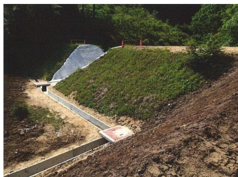
伏見堤廃止工事
