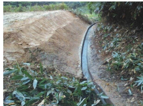
久根地区水路災害応急工事
