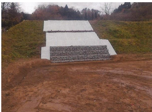
西谷本郷農地災害復旧工事
