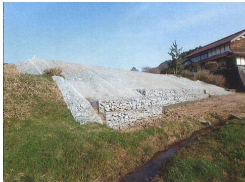
下古市農地災害復旧工事
