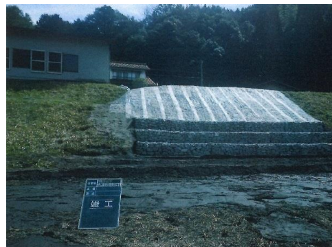
中口農地災害復旧工事
