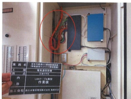
LANケーブル敷設
