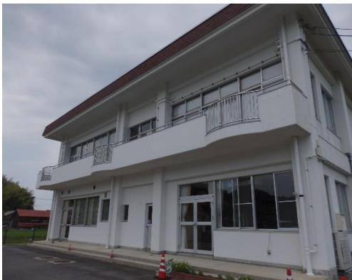
能義交流センター外壁塗装改修工事
