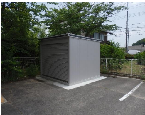
荒島交流センター倉庫設置工事
