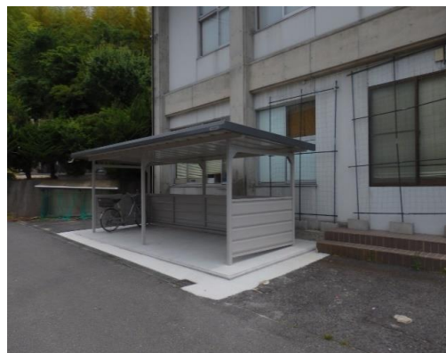
荒島交流センター自転車置場設置工事
