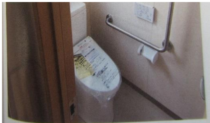
改修後の丸山集会所
