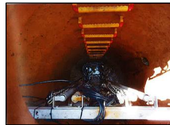
安来運動公園マンホールポンプ取替修繕
