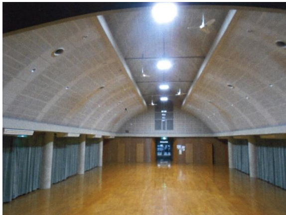
伯太中央交流センター大集会室電灯設備改修工事
