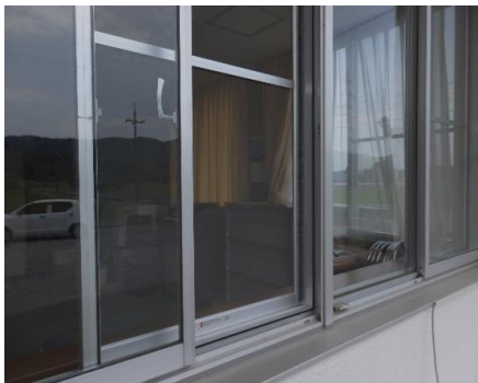
網戸設置工事
