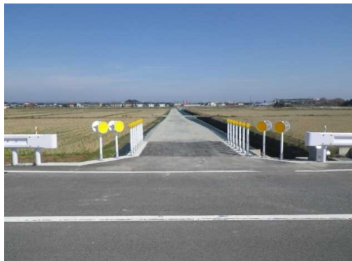
竣工写真1 南側より
