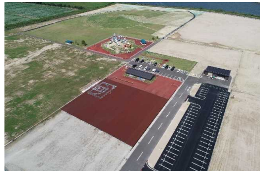
工事完了写真(東エリア)
