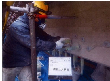
断面修復 樹脂注入 作業写真
