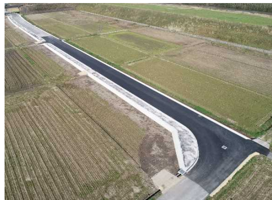
竣工写真2 南側より
