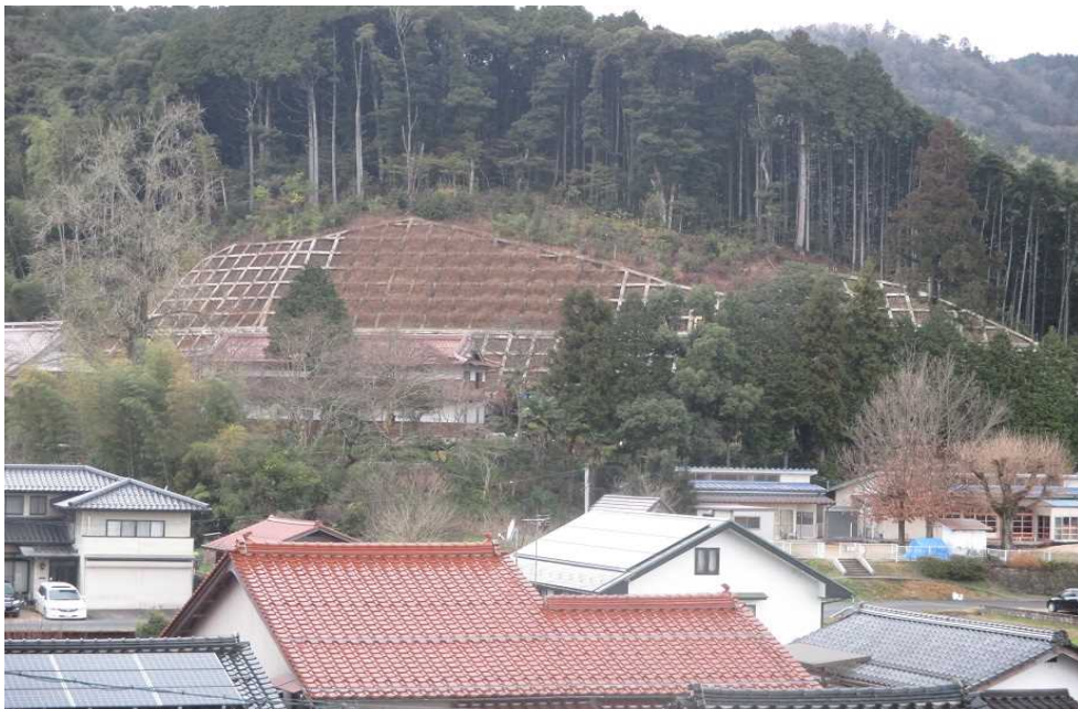
目谷地区急傾斜地崩壊対策事業
