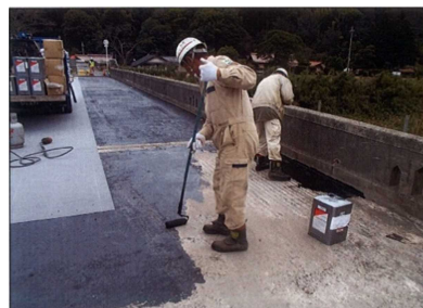
橋面防水シート 作業写真
