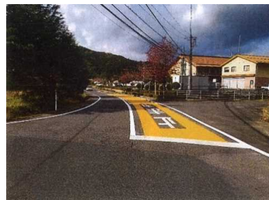
カラー舗装新設（伯太町東母里地内）
