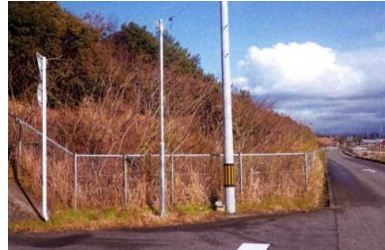
道路照明灯修繕（切川町地内）
