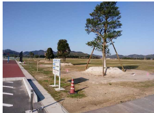
植栽工事完了写真(東エリア)
