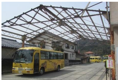
広瀬バスターミナル大屋根撤去
