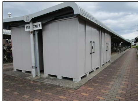
物品倉庫新設
