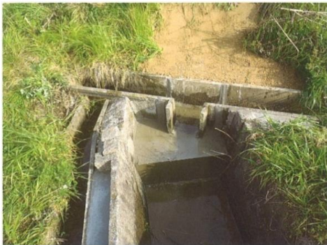
西赤江水路修繕
