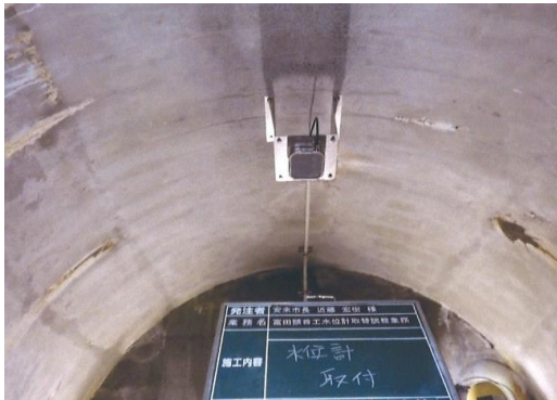
富田頭首工水位計取替
