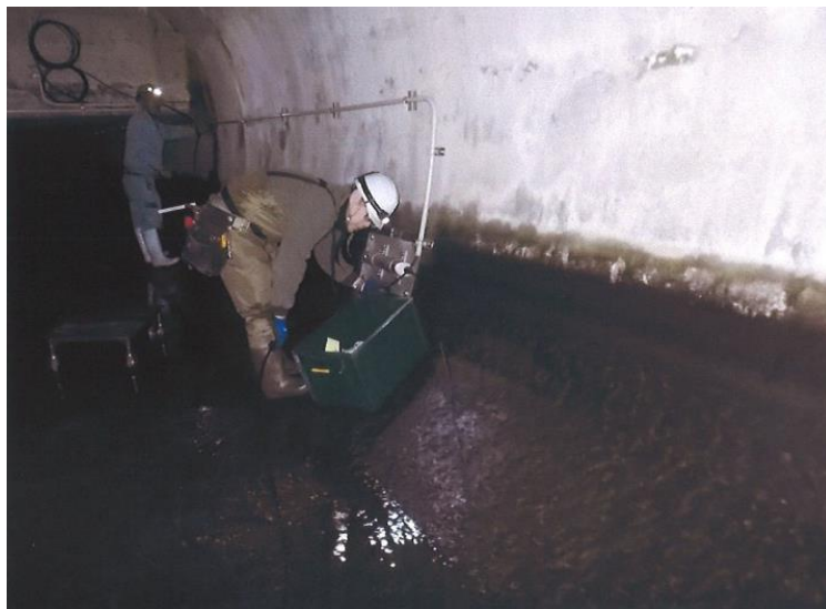
国道432号（八幡工区）社会資本整備総合交付金事業に伴う富田頭首工（流量計設備）移転工事
