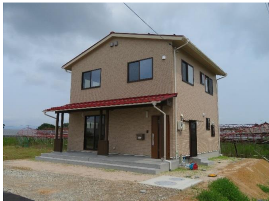
就農者定住促進賃貸住宅（下坂田1号）
