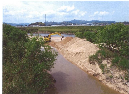
別石樋取水口土砂撤去
