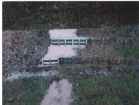
間ノ原水路修繕
