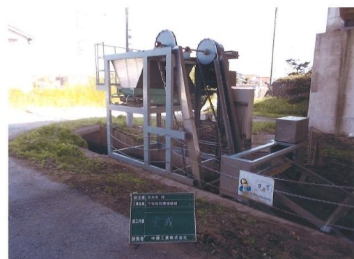
下坂田除塵機修繕
